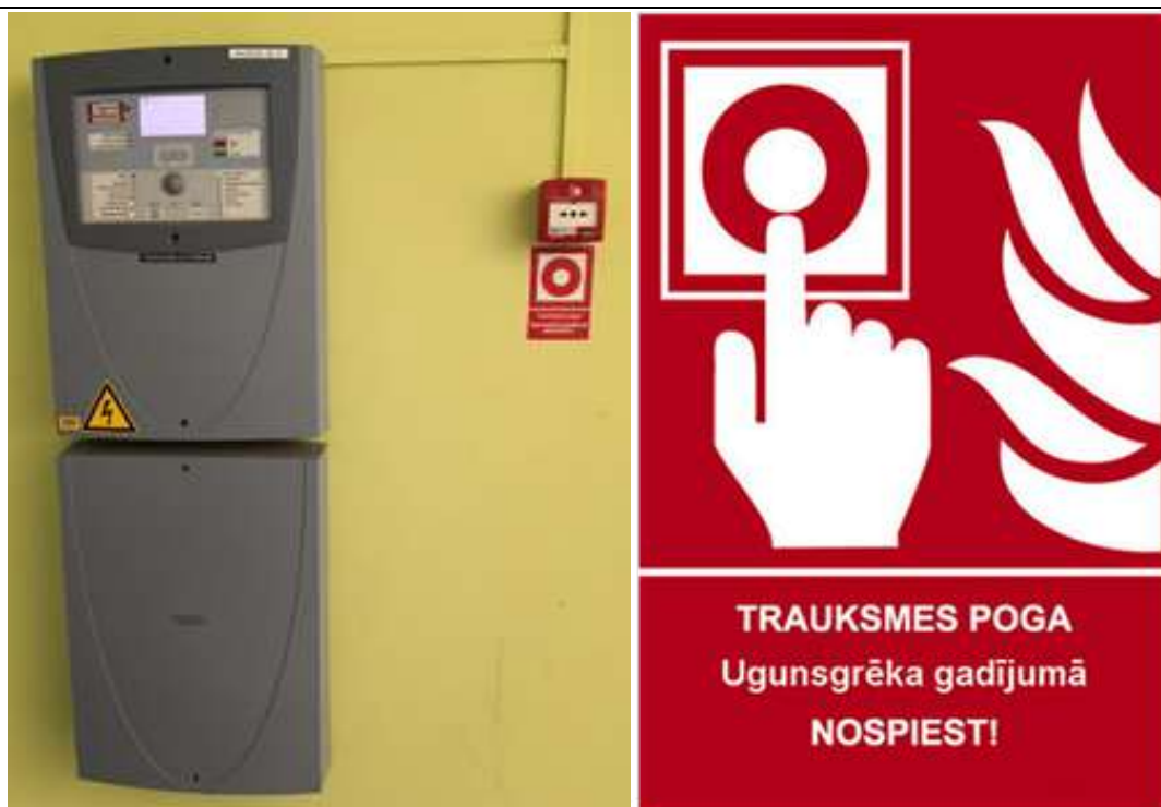
9.attēls. Korpusa K3 AUS panelis un trauksmes poga Figure 9. Body K3 AUS panel and alarm button
