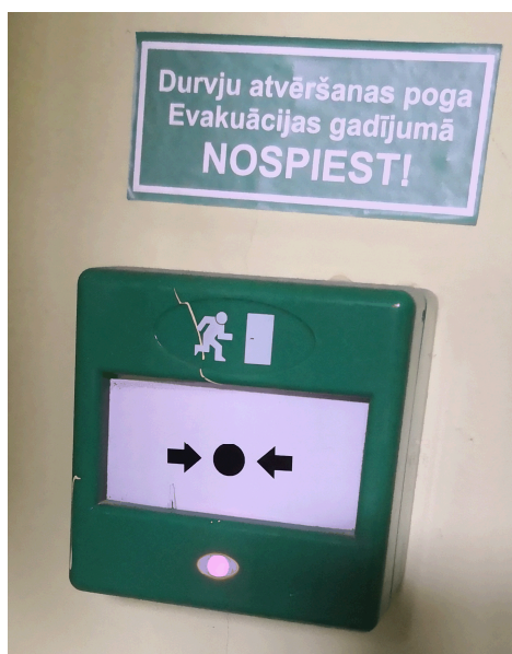
6.attēls. Pogas veidi, kas atvēr durvis evakuācijas ceļā Figure 6. Button types that will open the door on the escape route
