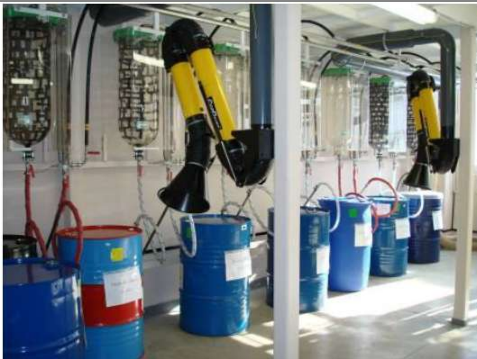
14.attēls. Korpuss K3, 60.telpa, izejvielu izfasēšanas telpa Figure 14. Building K3, room 60, room for unpacking raw materials
