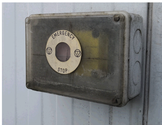
2.attēls. "EMERGENCY STOP" poga uz vadības pults / uz aukstumiekārtas ārējās sienas Picture 2. "EMERGENCY STOP" button on the control panel / on the outer wall of the refrigerator
