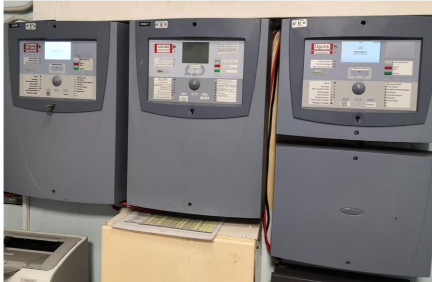
13.attēls. AUS uztveršanas paneļi Centrālajā apsardzes postenī
